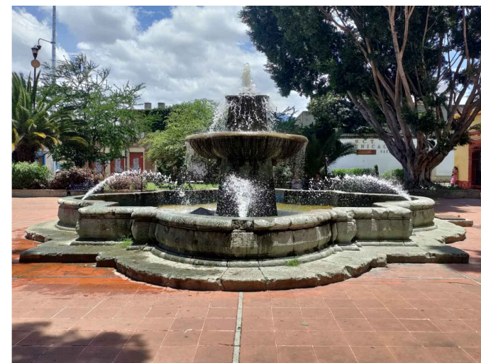
IMAGEN 04 VISTA EN PERSPECTIVA FUENTE DE CANTERA VERDE, ASEANTADO Y JUNTEADO CON MORTERO CAL ARENA. PISO DE LOSETA DE BARRO ROJO RECOCIDO CON ACABADO SEMIPULIDO RETICULADA CON ADOQUIN RECTANGULAR DE HORMIGON.
