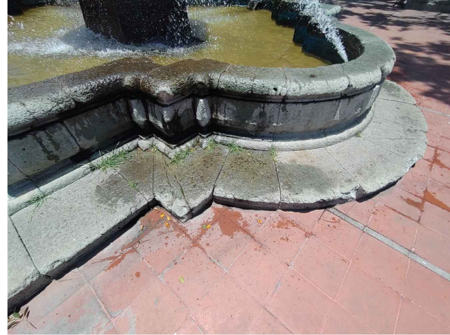
IMAGEN 01 Soldado perimetral de forma cruciforme constituido de sillares de cantera verde con una sección general 0.78m de largo por 0.16m de peralte y un ancho promedio de 0.50m a 0.65m
