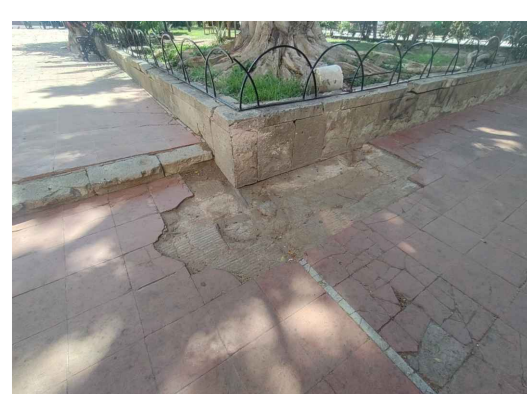
IMAGEN 04 DESPRENDIMIENTOS DE PIEZAS, HUNDIMIENTO Y PERDIDA DE NIVEL, OCASIONADOS POR INTemperismo, USO POR AGENTE HUMANO, CADUCIDAD DE MATERIALES Y SISMO
