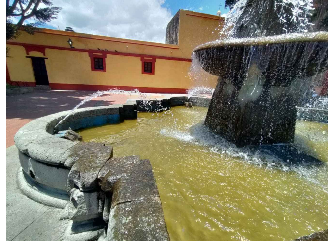
IMAGEN 02 Presencia de grietas, fisuras, erosonamiento, moho, saltire, desprendimientos de piezas, en brocal ocasionadas por intemperismo, deterioro fisico, agente uso humano, por asentamientos
