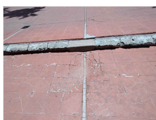
IMAGEN 02 PRESENCIA DE GRIETAS, FISURAS, DESPRENDIMIENTOS DE PIEZAS Y PERDIDA DE NIVEL, EN GUARNICION DE CANTERA OCASIONADOS POR INTemperismo, USO POR AGENTE HUMANO Y SISMO
