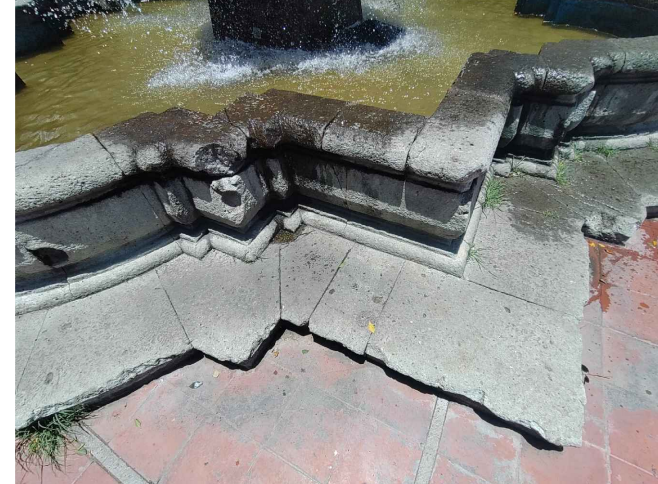
IMAGEN 01 Presencia de grietas, fisuras, erosonamiento, moho, saltire, desprendimientos de piezas, en soldado perimetral ocasionadas por intemperismo, deterioro fisico, agente uso humano, por asentamientos
